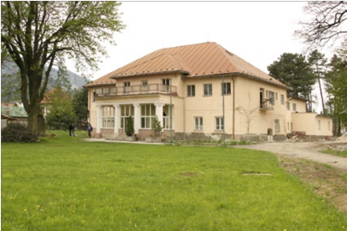
Foto 1: pôvodný vzhľad historickej budovy v priebehu rekonštrukčných prác
